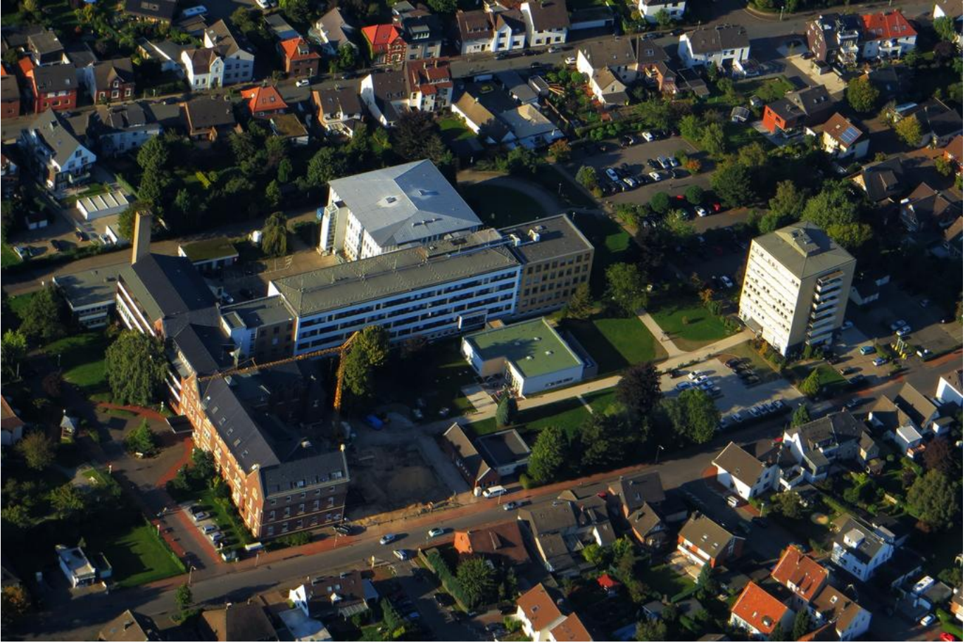
Abbildung: Luftaufnahme der Baustelle für die neue LWL Tagesklinik in Haltern am See. Bilderquelle: Jörg Hauff
