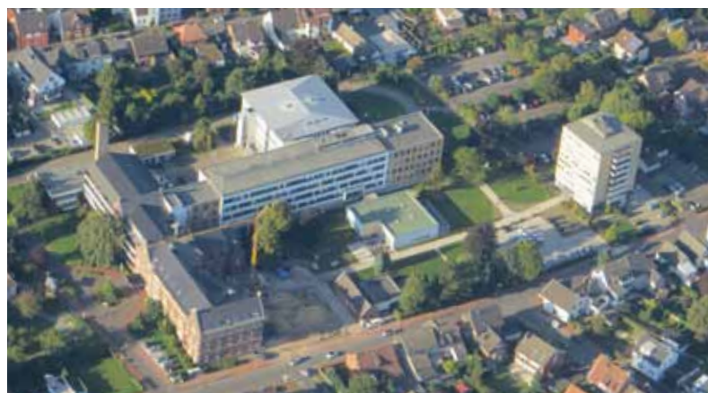
Baufortschritt: Die Erd- und Fundamentarbeiten, wie hier auf der Aufnahme von Ende September noch zu sehen, sind abgeschlossen, die Arbeiten im Erdgeschoss bereits angelaufen.
